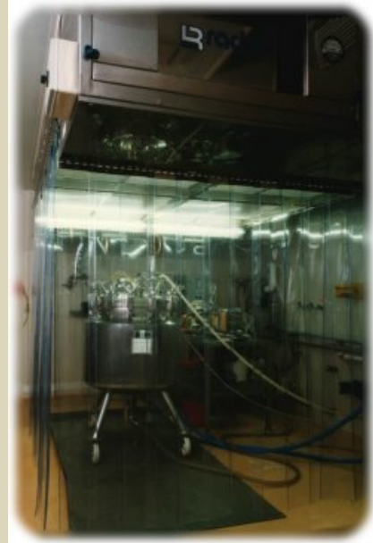
BV-2400x2400 típusú függőleges levegőáramlású lamináris box, rozsdamentes kivitel 100-as tisztatér az US209/E előírásának megfelelően
