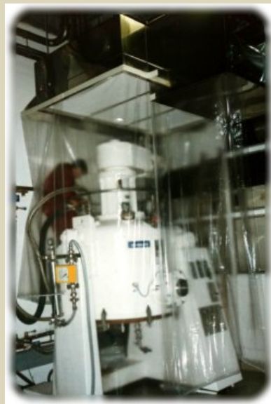
BV-1000x1800 típusú lamináris sátor függőleges levegőáramlással 100-as tisztatér az US209/E előírásának megfelelően
