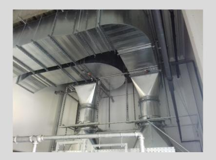
Die Kanäle und Formstücke werden aus beidseitig verzinktem Feinblech produziert. (Auf Kundenwunsch können die Kanäle und Formstücke auch aus Aluminium oder Niroblech hergestellt werden). Die max. zulässige Druckdifferenz beträgt 2500 Pa bei einer Luftgeschwindigkeit von 8 m/sec. Ohne anderweitige Vorschrift produzieren wir die Kanäle mit einer zugelassenen Luftleckage von 2,0 x 10<sup>-3</sup> - 3,0 x 10<sup>-3</sup> m<sup>3</sup>/sec/m<sup>2</sup>.
