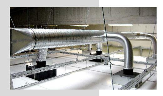
Die runden Sprirorohre und Formstücke von Radel & Hahn Zrt aus beidseitig verzinktem Streifenblech sind sowohl für lüftungstechnische Systeme als auch für andere Verwendungszwecke unter Beachtung der notwendigen Luftgeschwindigkeit, Druckdifferenz und Dichtheit geeignet.
