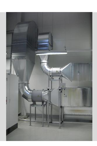
Bei Luftkanälen mit großem Querschnitt werden die verarbeiteten Blechplatten durch einen inneren Stehfalz zusammengefügt. Die Kanten der Luftkanäle werden mit einem Pittsburg-Falz hergestellt. Die Blechtafeln für die Kanäle mit großem Querschnitt werden zusätzlich mit Gestängen versteift.
