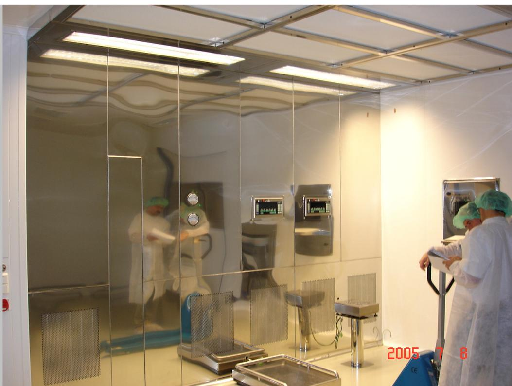
Luftmenge außerhalb des Arbeitsraumes, die durch HEPA-Filter und Einlaßdüsen strömt: 1200(2x600) m<sup>3</sup>/h
