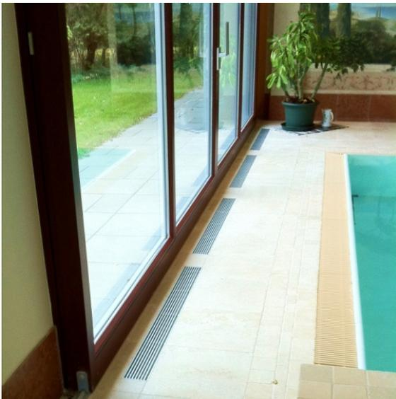
Die Zuluftkanäle werden normalerweise im Beckenumgang angeordnet. Über Schlitze in der Deckenkonstruktion wird die Luft über Ausblasgitter in die Halle geblasen. Die Ausblasgitter bestehen aus natur eloxierten Aluminium und sind begehbar. Die Lamellen sind 15 Grad gegen die Fensterfläche geneigt, so dass vor den Fenstern ein warmer Luftschleier gelegt wird. Dadurch wird die Kondensation an den Fenstern vermieden.
